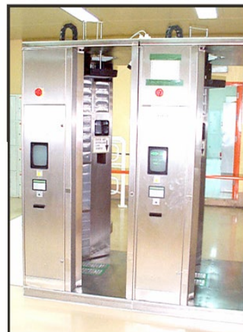
Equipos para controlar la salida de personal y pequeñas herramientas
