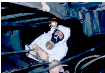
Trabajo en el interior del cajón
