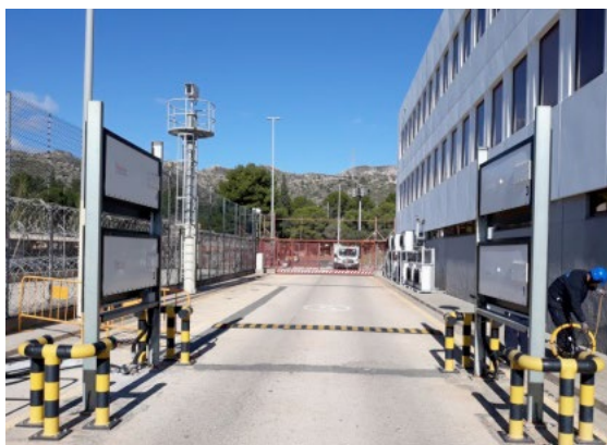
Pórtico a la entrada y salida de vehículos al doble vallado
