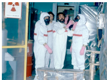
Acceso PR al cajón del reactor
