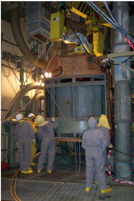
Motor bomba sistema de recirculación B33
