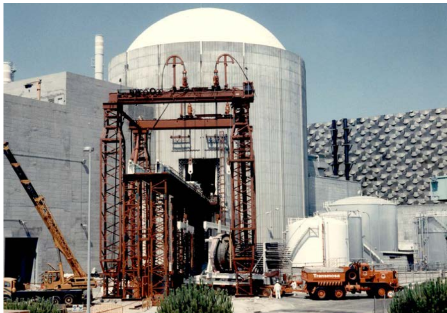
Apertura de Contención para el cambio de los Generadores de Vapor
