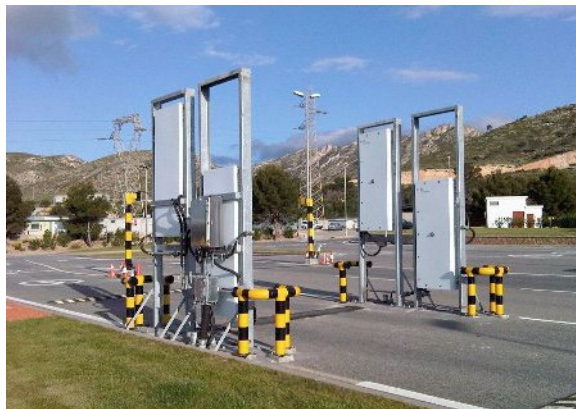
Pórtico a la salida de vehículos de la instalación
