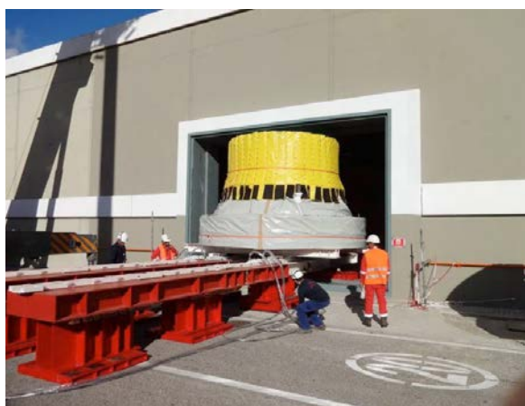
Tapa sustituida en entrada al Almacén de residuos
