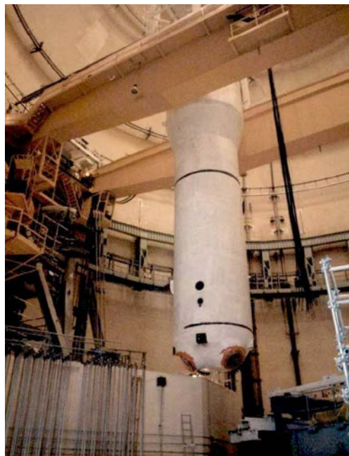
Maniobra de salida de un Generador de Vapor
