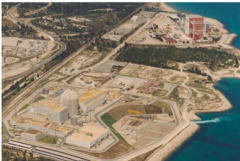
Central Nuclear de Vandellós II
