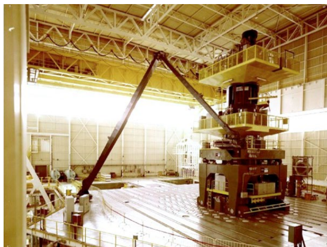
Máquina de manipulación de combustible acoplada al reactor
