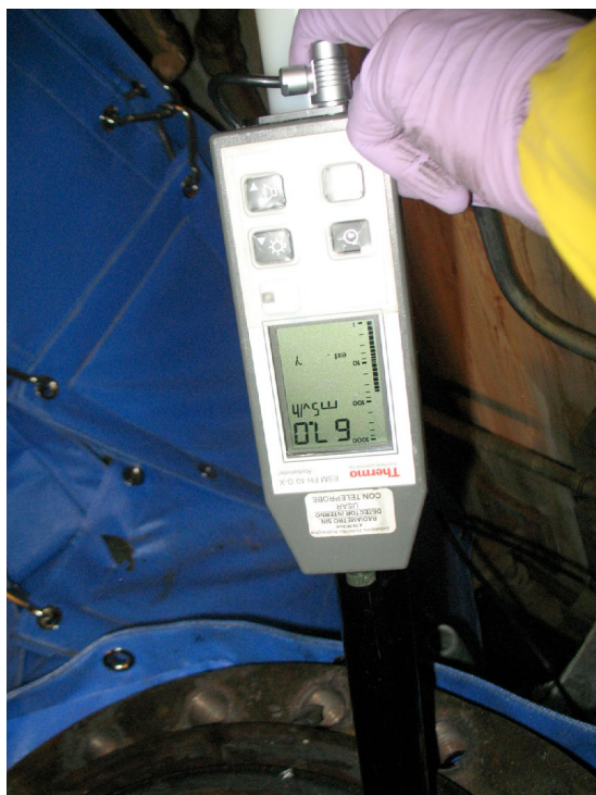
Nivel de radiación interior válvula sistema B33
