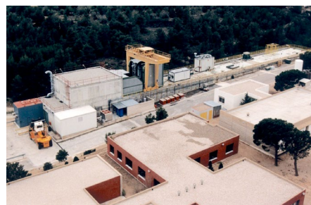
Taller de grafito sobre el silo de camisas de combustible
